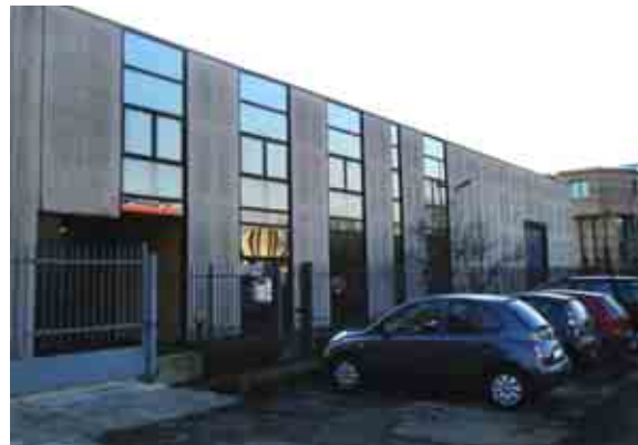
L'esterno dello stabilimento Termogamma
