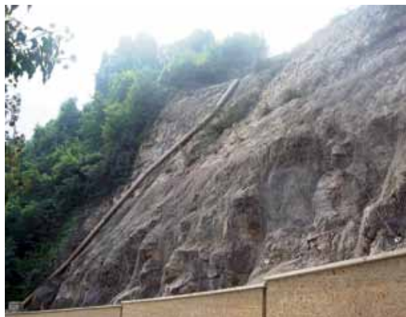
Orvieto (TERNI), SP111 della Badia. Il sito prima e dopo l'intervento con i PRATI ARMATI®. Litotipo: piroclastiti tufacee alterate e affioramenti basaltici.
