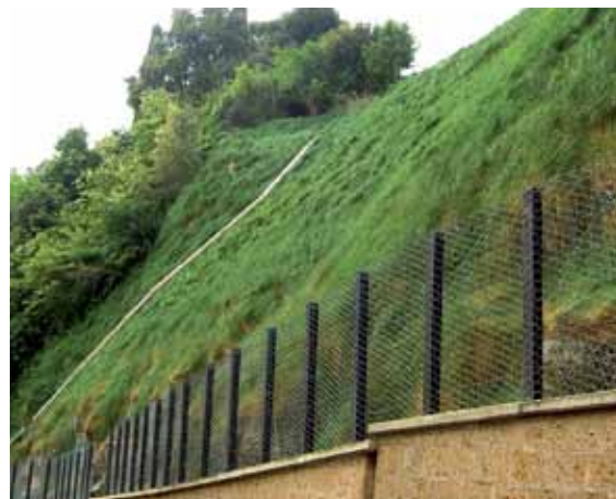
Orvieto (TERNI), SP111 della Badia. Il sito prima e dopo l'intervento con i PRATI ARMATI®. Litotipo: piroclastiti tufacee alterate e affioramenti basaltici.
